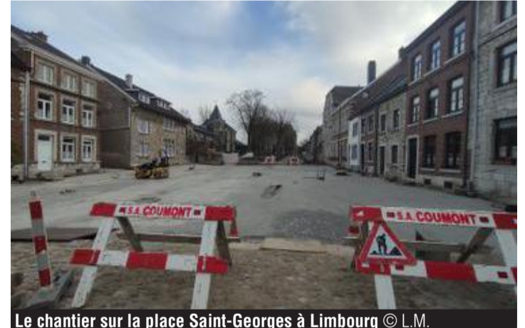
Le chantier sur la place Saint-Georges à Limbourg © L.M.
