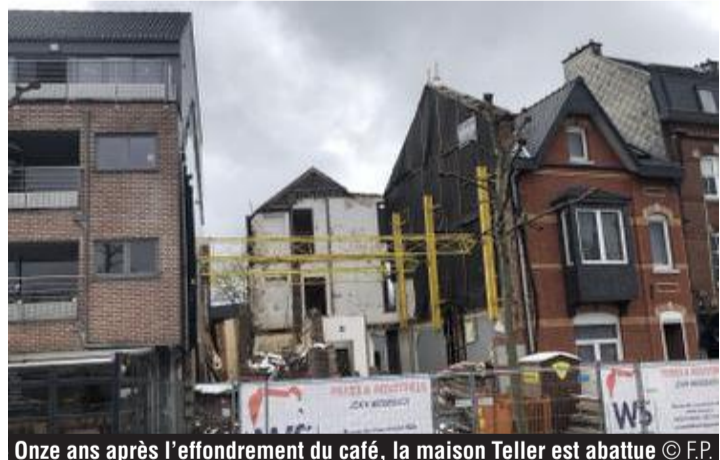
Onze ans après l'effondrement du café, la maison Teller est abattue © F.P.
